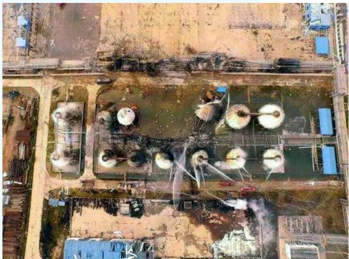
石大科技液化烃倒罐作业爆炸事故
